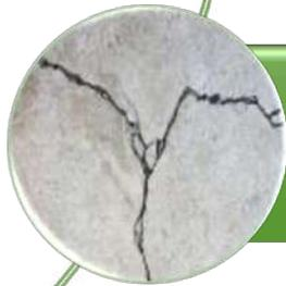
Las grietas por restricción de la contracción pueden reducir el desempeño en la vida de la estructura (por ejemplo, grietas que permiten la fuga de agua en estructuras de este tipo) o causa problemas generales de durabilidad (por ejemplo, corrosión del refuerzo en acero)
