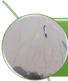
La contracción por secado es una característica del concreto que si es mal controlada o manejada, puede conducir a problemas de servicio, reduce la durabilidad e incluso puede presentar fallas del sistema. En pisos, la contracción causa roturas o fallas que son estéticamente inaceptables y puede impedir el paso de llantas de montacargas ó el tráfico peatonal, e impedir o dificultar la limpieza lo cual reduce la durabilidad.
