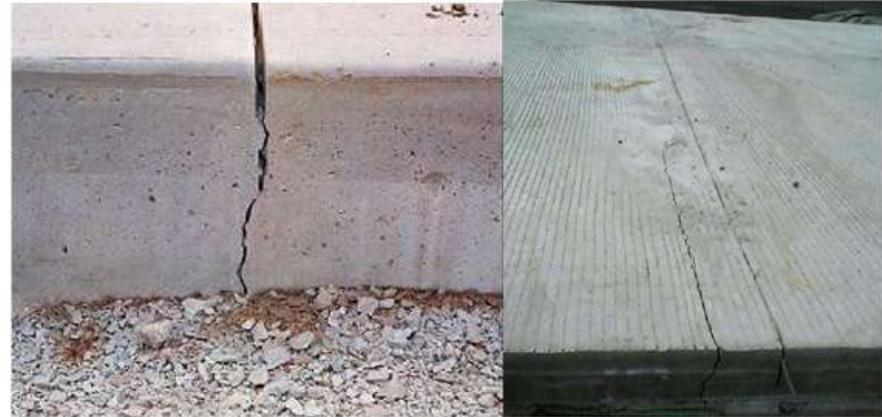
Figura 1. El corte ocasiona la aparición de la fisura en la junta (Taylor P.; et al, 2007)
