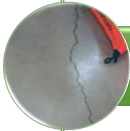
La contracción en losas también causa alabeo, lo cual puede resultar en deterioro de las uniones, problemas en los montacargas y rotura en las estructuras.
